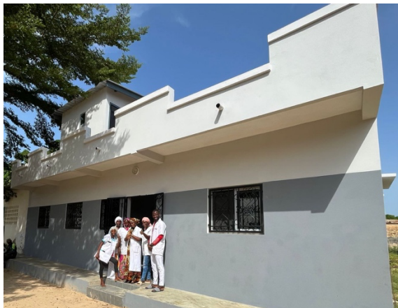
Uitbreiding van de "Poste de Santé"
